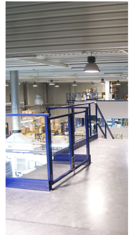
Entreplanta Kimer con suelo de tablero y zócalo.
