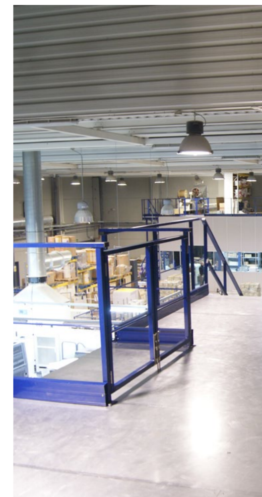
Mezzanine Kimer avec plancher en panneaux et plinthe.
