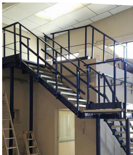
ESCALERA CON RELLANO
